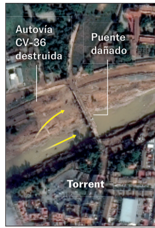
1 El cauce de la rambla del Poyo por Torrent es ancho y profundo, lo que probablemente evitó la devastación de la localidad.
